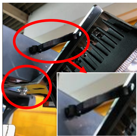
図3 脱落防止用インシュロック取付
